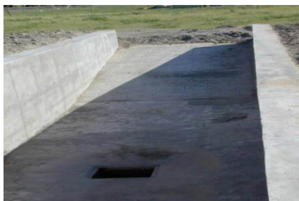
تصویر ۱- تمیز کردن سیلو و مشاهده سیستم جمع‌آوری ابداعی آب اضافی سیلو (تصویر سمت راست) (عکس از نگارنده - سال ۱۳۹۴)
