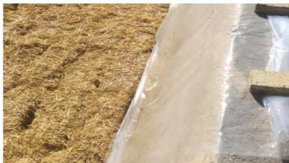
تصویر ۴- پوشاندن دیواره‌های سیلو با پلاستیک یکپارچه و چینن یک‌لایه پرس کاه باز نشده در کف سیلو به‌منظور جذب شیرابه‌ها (عکس از نگارنده - سال ۱۳۹۳)
