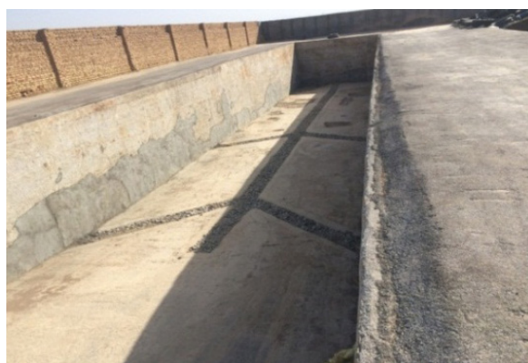
تصویر ۱- تمیز کردن سیلو و مشاهده سیستم جمع‌آوری ابداعی آب اضافی سیلو (تصویر سمت راست) (عکس از نگارنده - سال ۱۳۹۴)
